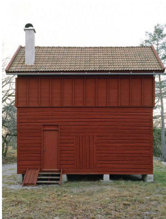
Exempel på timmerhus som kompletterades med modern regelstomme där färgen ger en sammansatt arkitektonisk ordning. För kyrkstaden används med fördel plåttak istället för tegeltak.
