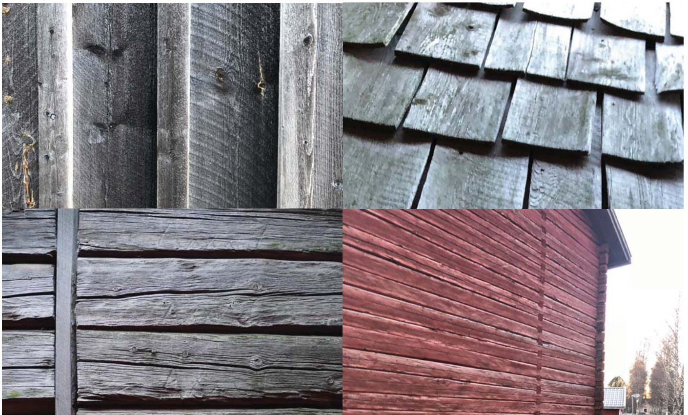
Exempel på kyrkstugornas olika fasader med liggtimmer, panel och fjäll.
