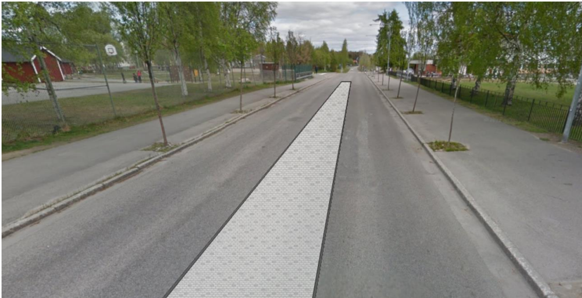
Olof Palmes gata efter en ombyggnad där asfalten mitt i gatan ersätts av storgatsten.
