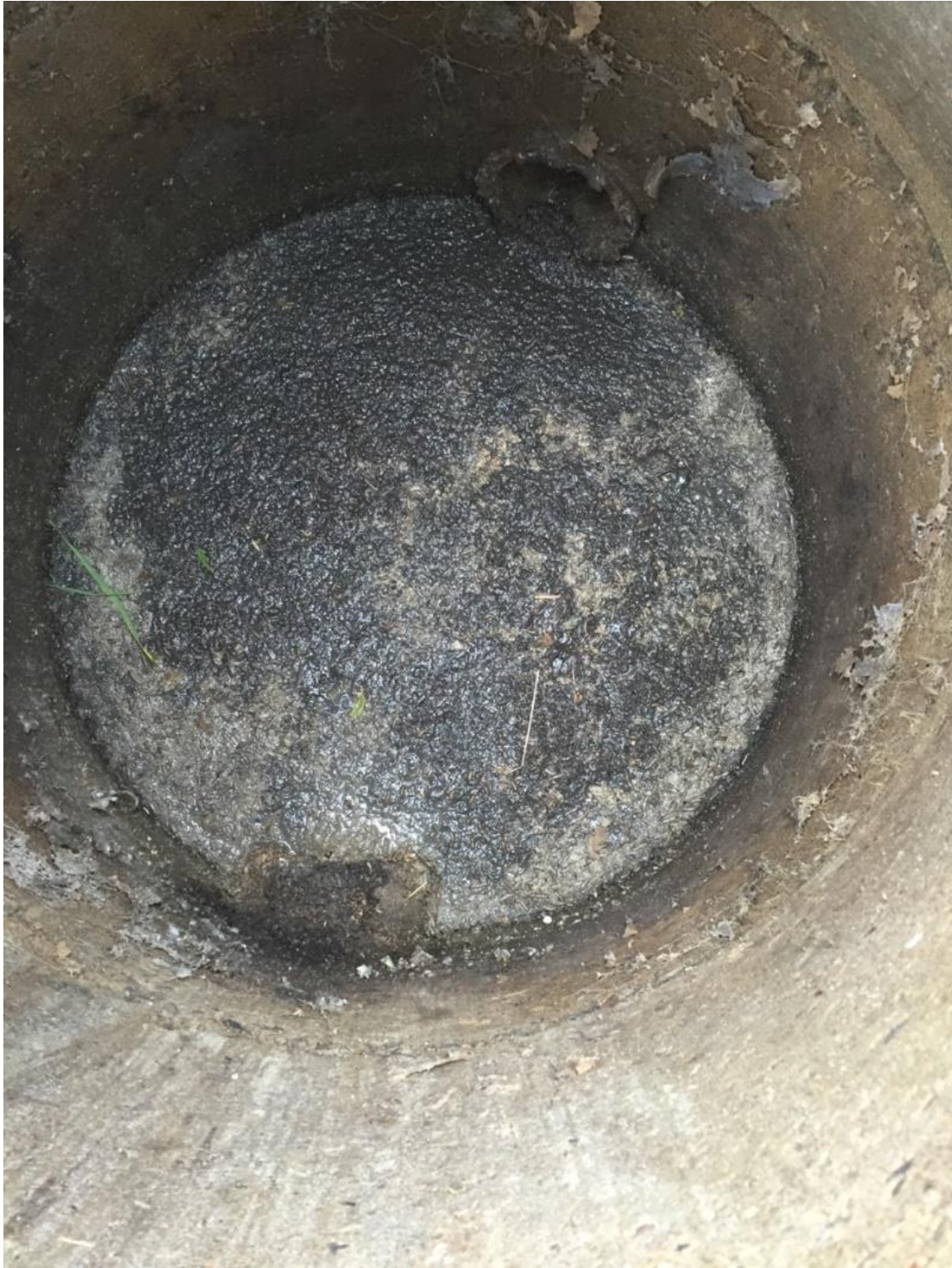
Figur 5. Är en enkammarbrunn utan t-rör som enligt ägare har infiltration som efterbehandling. Denna anläggning är också ett exempel på en rödklassificerad brunn, bl.a. för att det är krav på att ha trekammarbrunn när toalett är inkopplat.
