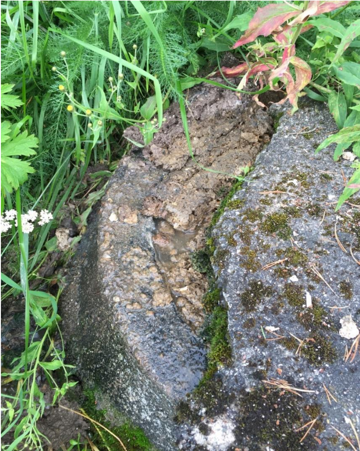
Figur 4. Är ett exempel på en rödklassificerad brunn. Brunnen är totalt överfull och är därmed ett bra exempel på de röd klassificerade som egentligen bör ha en egen färg för att det är en brist som är akut.
