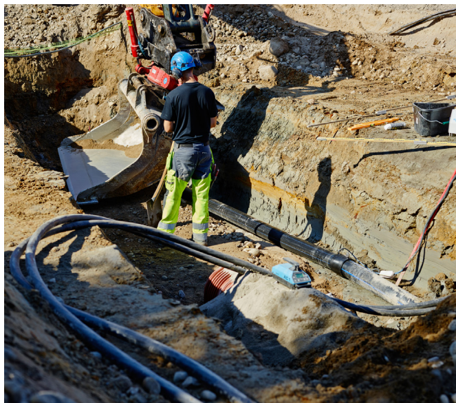
För säkra leveranser – Byte av vatten- och avloppsledningar i Annelund.
