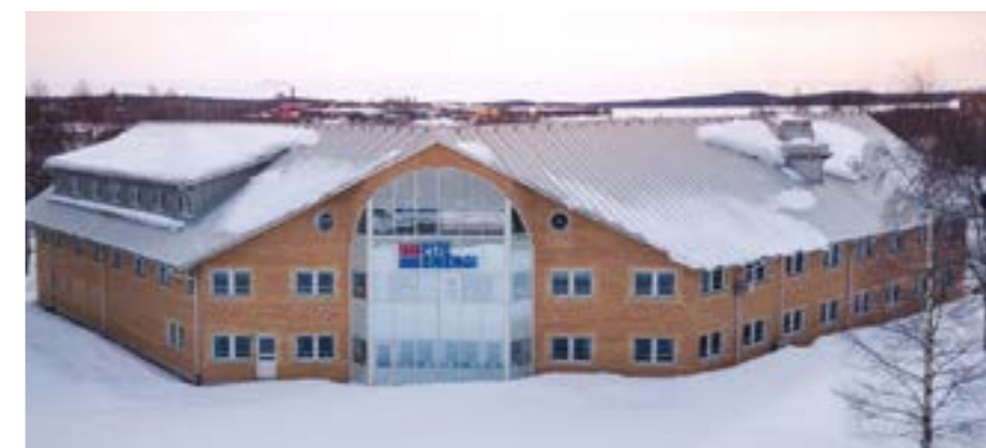
Energihuset PiteEnergi. Foto: Jessepix
