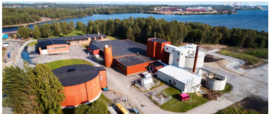
Pirevas Avloppsreningsverk på Sandholmen. Piteborna spolar ner 54 ton skräp i avloppet varje år, skräp som förstör avloppsledningar och pumpstationer, samt gör överkan på miljön. Det är viktigt att arbeta proaktivt med underhåll av vattenleveranser. Foto: Maria Fäldt
